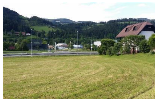
Slika 10: Območje 3. etape 1. faze ceste - vzhodna stran ( pogled proti novemu krožnemu križišču)
