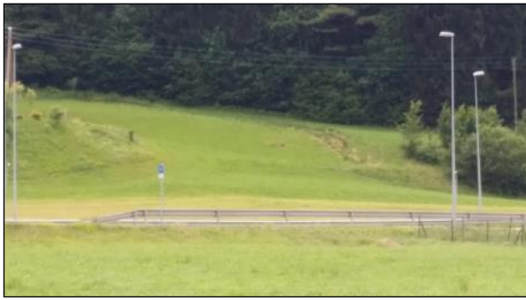
Slika 7: Območje sanacije hudournika
