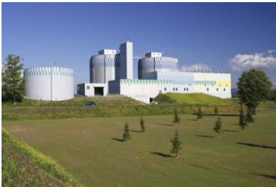
Slika 12.30: Pogled na objekte za obdelavo blata na čistilni napravi Ljubljana 21 .
