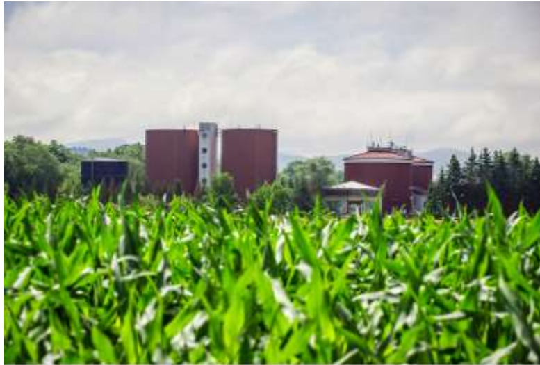
Slika 12.31: Čistilna naprava Domžale - gnilišča in plinohram 23 .
