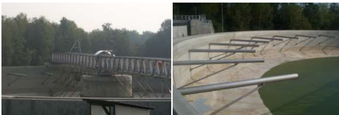
Slika 12.8: Naknadni usedalnik.
