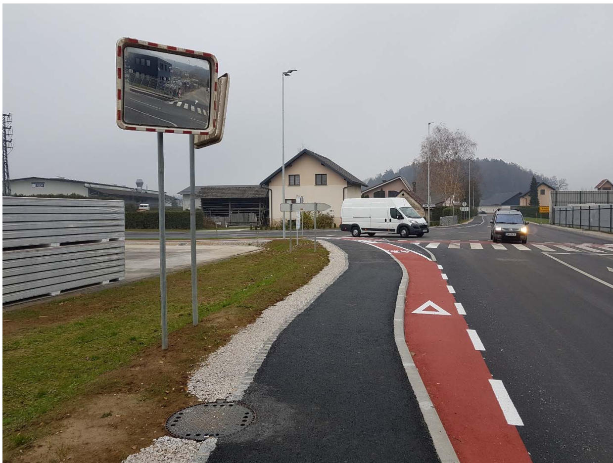
Slika 9: Oglledala za zagotavljanje preglednosti s priključka Dolenji Podboršt
