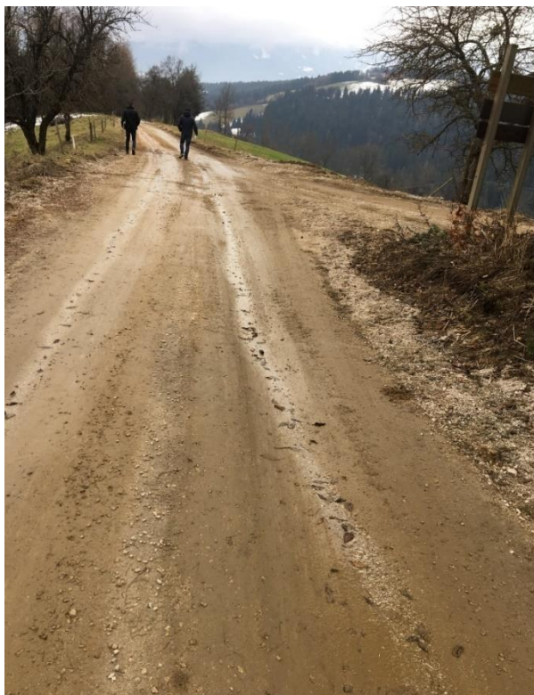
Slika: Pogled na konec meje obdelave na lokalni cesti LC 350 381
