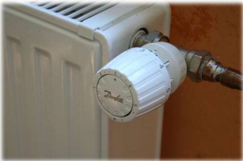
Za prihranek energije smo namestili termostatske ventile.
