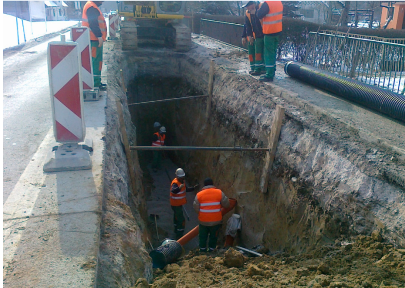
Slika 6: Kanalizacija Nova Dobrava 3
