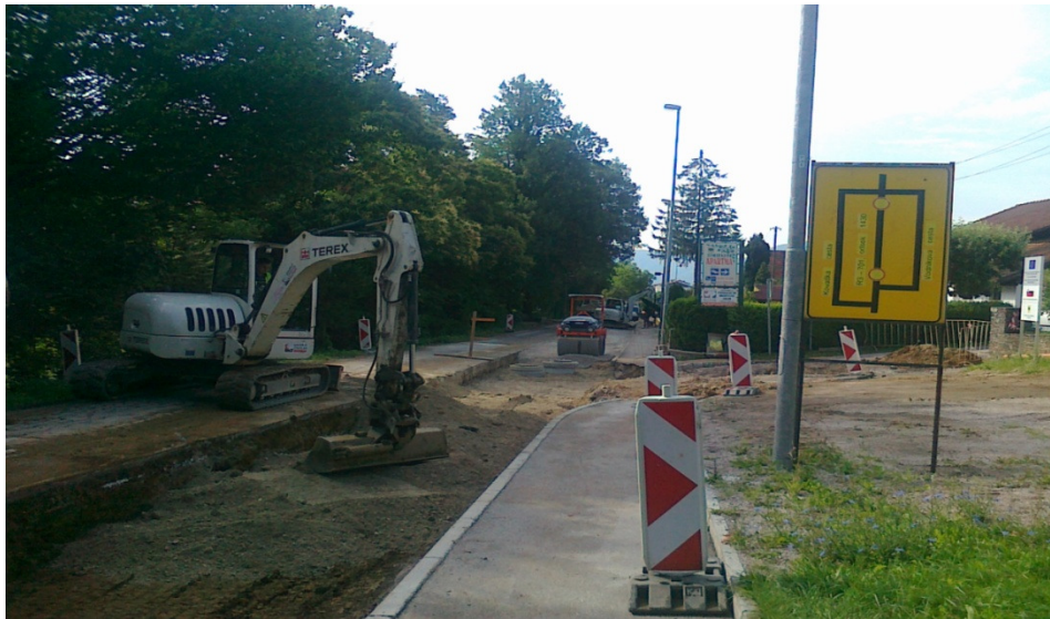
Slika 4: Kanalizacija Nova Dobrava 2
