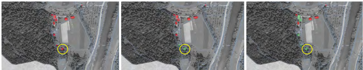
Slika 23: Prikaz objektov glede na priključenost na infrastruktura omrežja GJI (priključeni so zeleni, nepriključeni so rdeči) – levo kanalizacija, sredina vodovod, desno elektrika - območje obravnave je označeno z rumenim krogom (vir svetovni splet, PISO za območje občine Mozirje, 2022).
