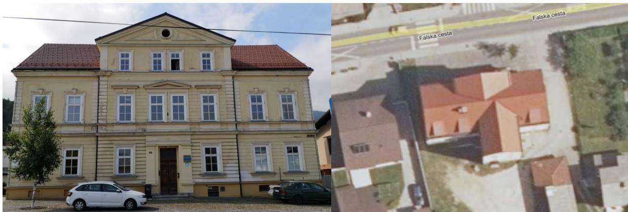
Slika 2.6: Objekt Športni park Ruše - bazen in njegova mikrolokacija Vir: Razširjeni energetski pregled, CID – glasbena šola Ruše, julij 2021.
