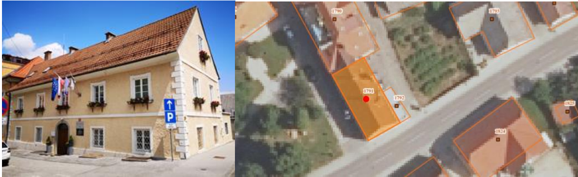
Slika 2.3: Objekt Občina Ruše - upravna stavba in njegova mikrolokacija Vir podatkov: Razširjeni energetski pregled, Občina Ruše - upravna stavba, julij 2021
