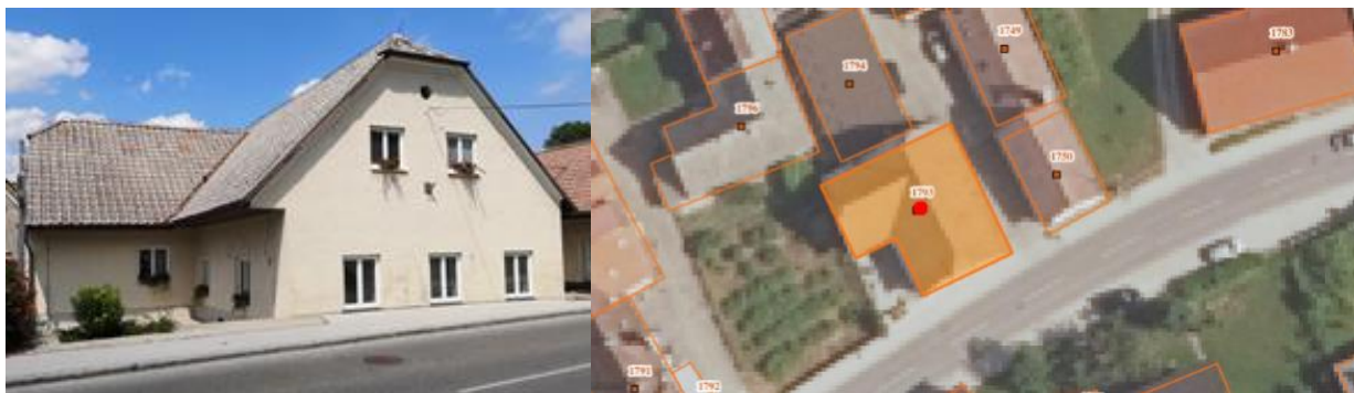
Slika 2.5: Objekt Režijski obrat Ruše in njegova mikrolokacija Vir: Razširjeni energetski pregled, Režijski obrat Ruše, julij 2021.
