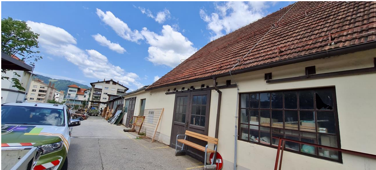
Slika 2.11: Objekt Režijski obrat - delavnice
