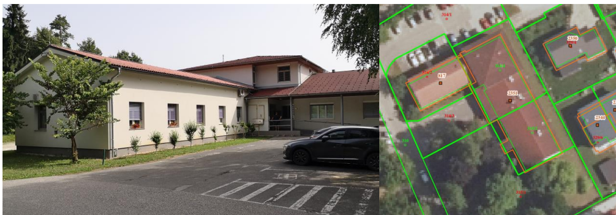
Slika 2.9: Objekt Zdravstvena postaja Ruše in njegova mikrolokacija Vir: Razširjeni energetski pregled, Zdravstvena postaja Ruše, julij 2021.
