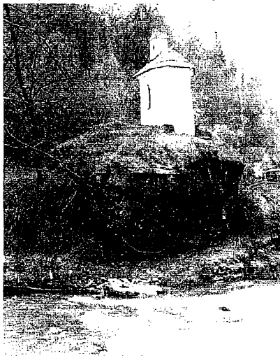
Slika13. Izvedba podvrtavanja na levi strani kapelice zaradi konfiguracije terena (takoj za kapelico potekata državna cesta in železnica) tehnično ni bila izvedljiva.
