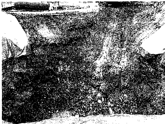
Slika19. Zaradi različnih materialov ter izrazite slojevitosti je obstajala nevarnost zdrsov.
