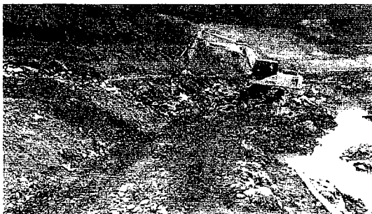
Slika 3. Izkop v 6. kat tal – dolbljenje gnajsa (točka A)
