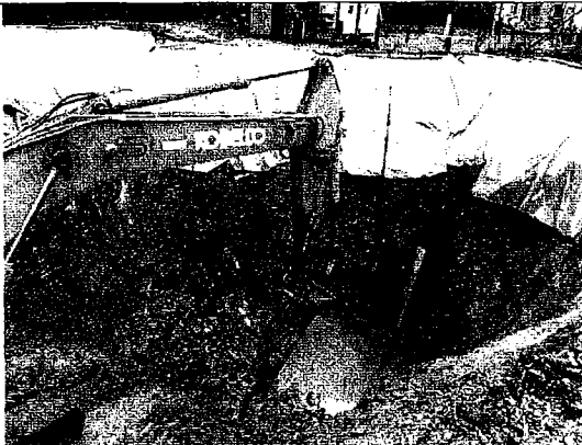
Slika18. Nadaljevanje izkopa. Zemljina (kamnina) je bila ob prisotnosti talne vode ter izpostavljenosti atmosferi nestabilna.
