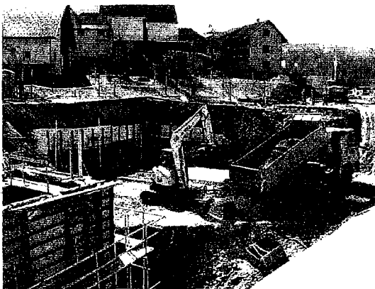
Slika 23. Stanje po izvedbi varovalnih ukrepov.
