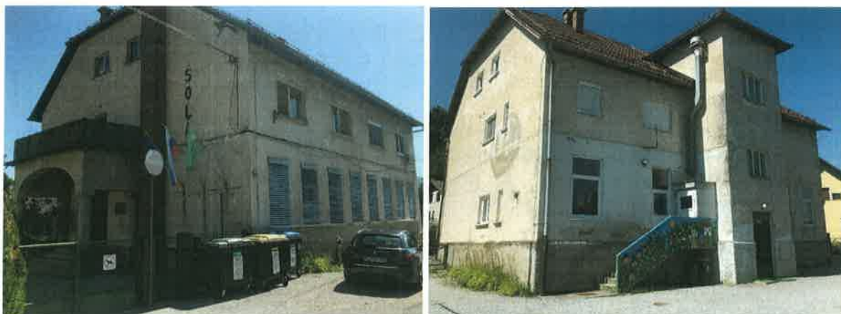
Sliki 1 in 2: Pogled na objekt POŠ Jezero ( 23.07.2019)
