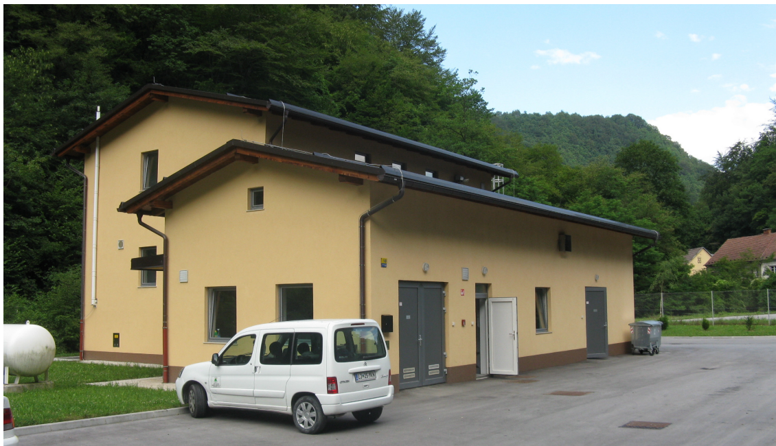
Slika št. 1: Objekt centralne čistilne naprave
