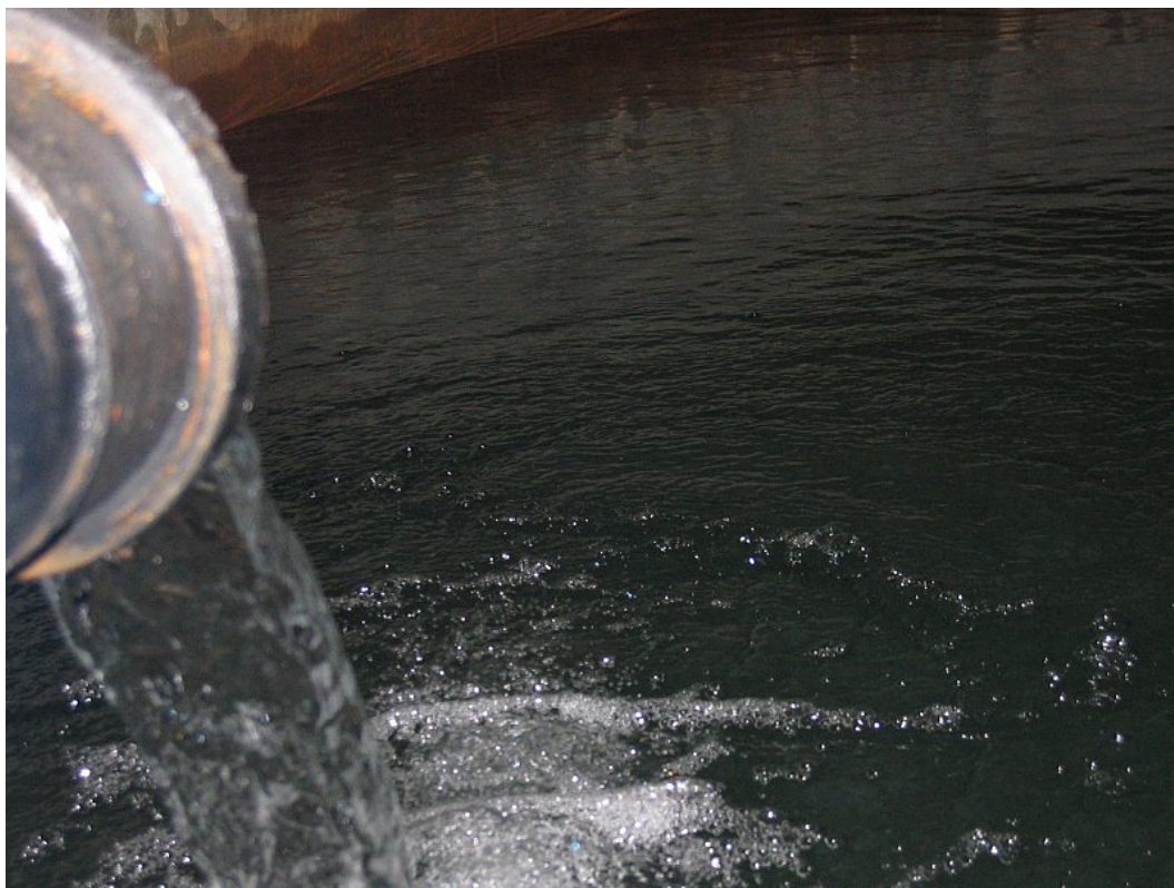
Slika št. 4: vodohran
