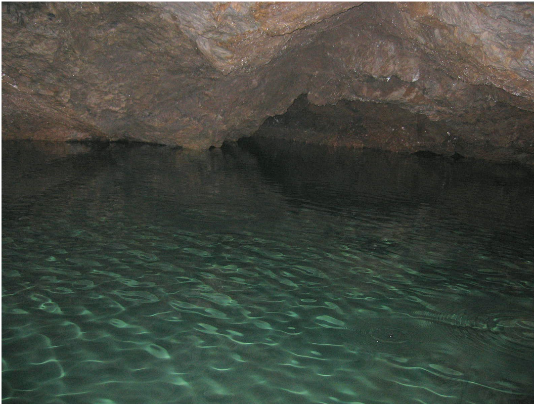
Slika št. 5: notranjost zajetja Mitovšek
