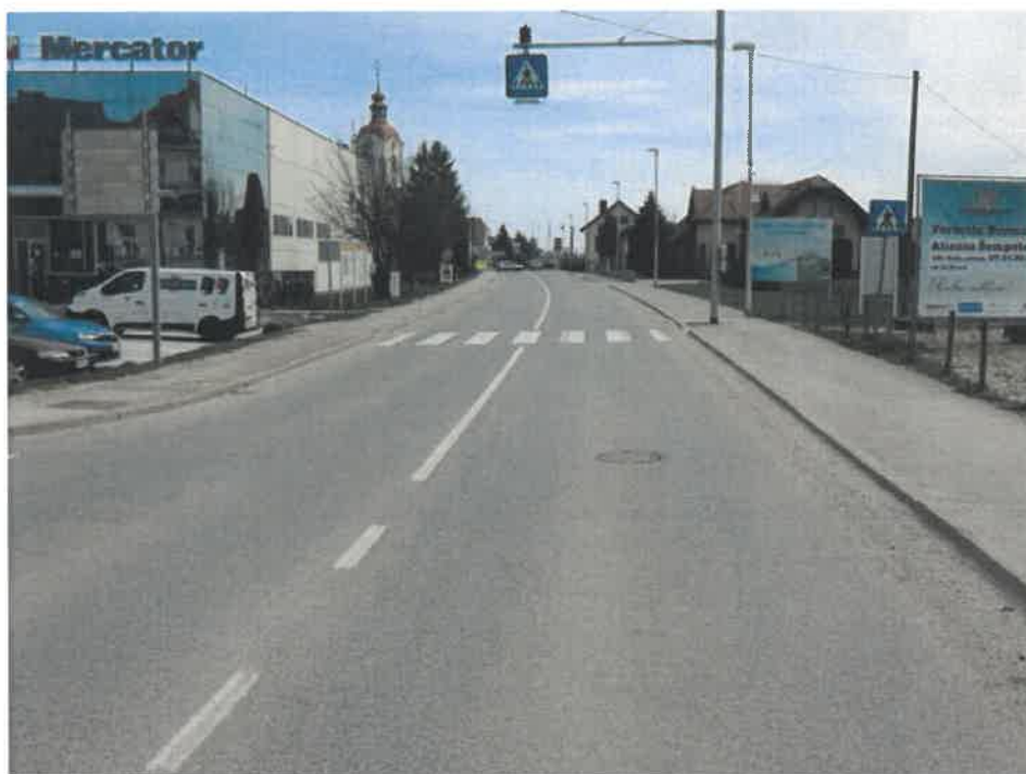
Slika 44: RT-929/1332 (Hoče - Pohorska vzpenjača), stac. km 0,380 - pogled na zavarovani šolski prehod
