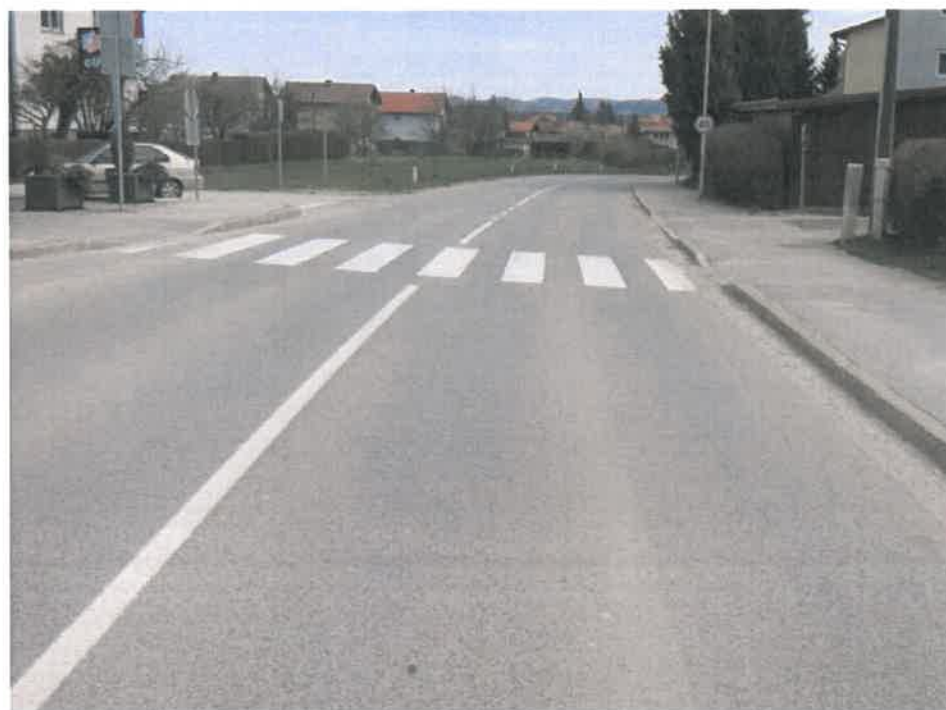
Slika 46: RT-929/1332 (Hoče - Pohorska vzpenjača), stac. km 0,690 - pogled na prehod za pešce pri trgovini "Top avto"
