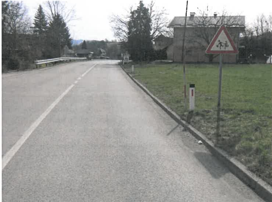
Slika 41: RT-929/1332 (Hoče - Pohorska vzpenjača), stac. km 3,340 - pogled proti priključku k podružnični OŠ
