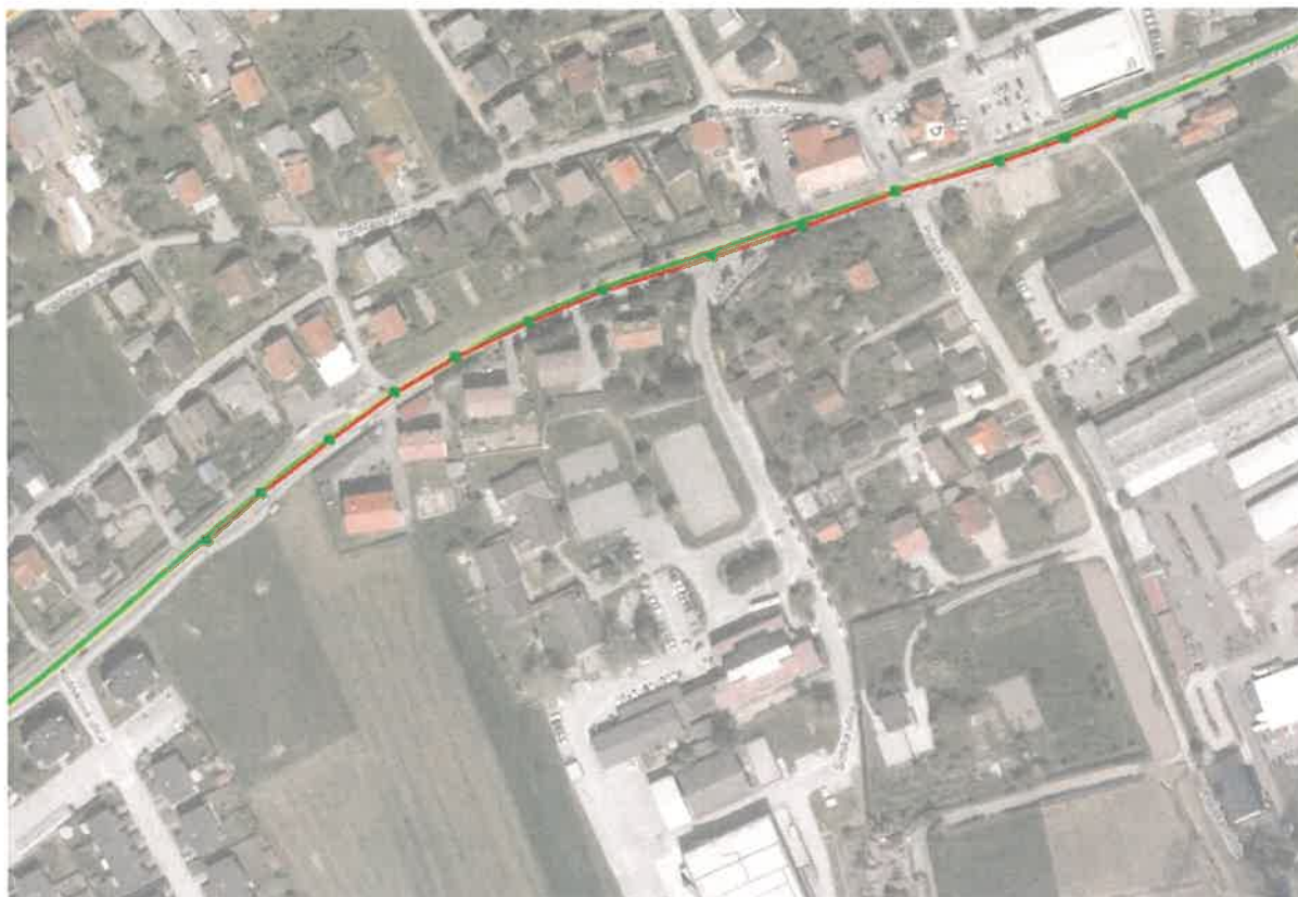
Slika 1: OŠ Dušana Flisa Hoče - obravnavani odsek na RT-929/1332 (Hoče - Pohorska vzpenjača) od km 0,300 do km 0,700
