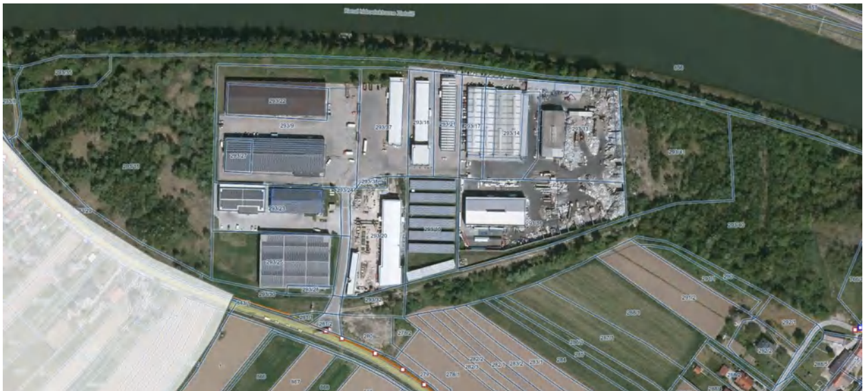
Slika 8 Prikaz obstoječega elektroenergetskega, telekomunikacijskega in vodovodnega omrežja (vir: št. proj. 19 – OPPN - 02, april 2019 UMARH d.o.o.)
