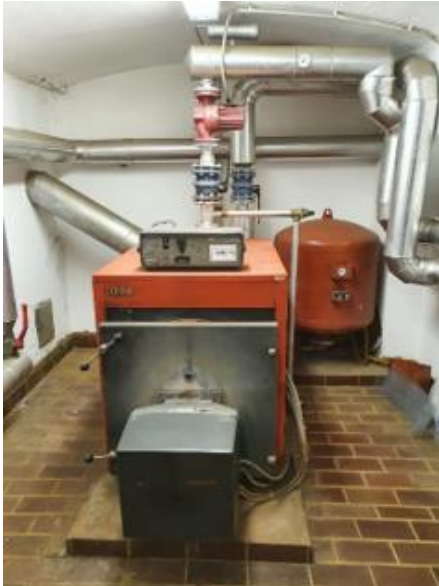
Slika 20: Kotel Unical M 200 in ogrevne veje s obtočnimi črpalkami
