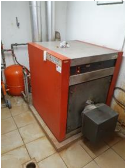
Slika 12: Kotel Feroterm Stadler Tip 80 in ogrevne veje s obtočnimi črpalkami
