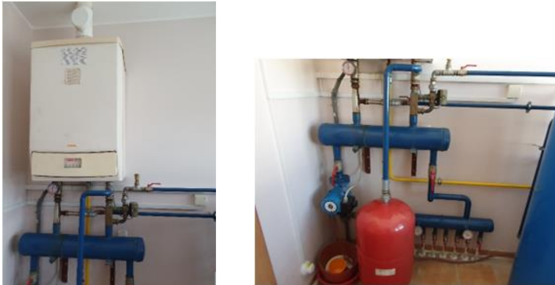
Slika 36: Plinski stenski kotel Immergas Victrix 50 in razdelilnik ogrevne vode s obtočno črpalko
