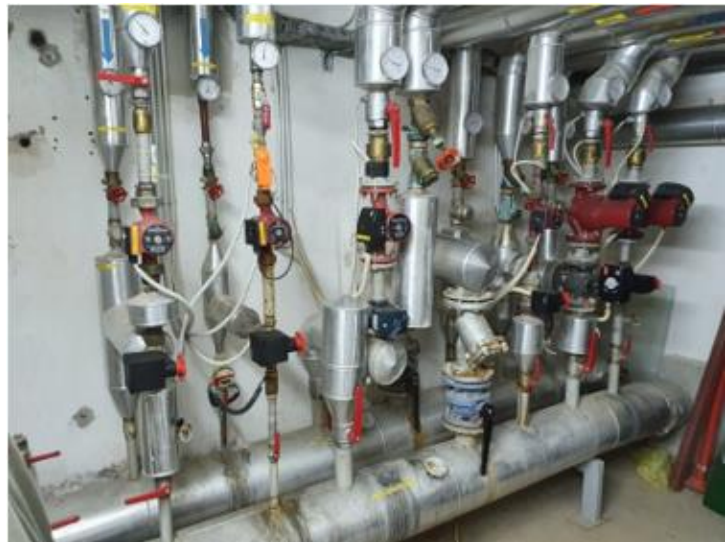
Slika 20: Kotel Unical M 200 in ogrevne veje s obtočnimi črpalkami
