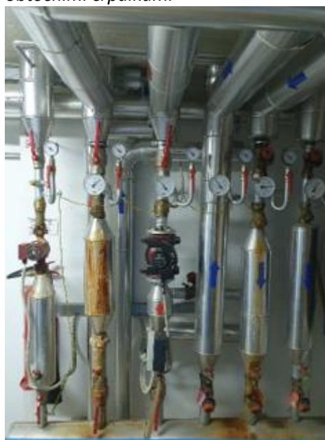
Slika 28: Kotel Buderus Logano G215 in ogrevne veje s obtočnimi črpalkami
