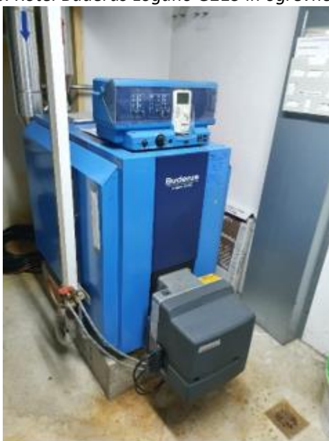
Slika 28: Kotel Buderus Logano G215 in ogrevne veje s obtočnimi črpalkami
