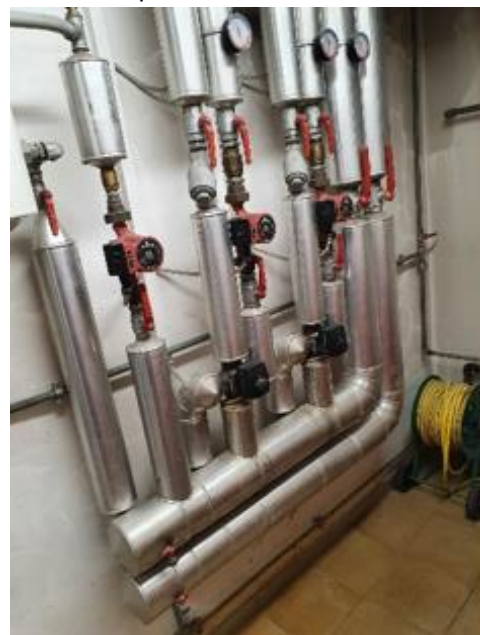
Slika 12: Kotel Feroterm Stadler Tip 80 in ogrevne veje s obtočnimi črpalkami
