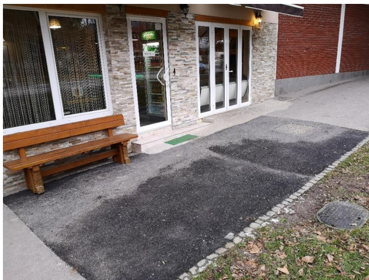
Sanacija površine pločnika in okolice jaška (Vir: Občina Slovenska Bistrica)
