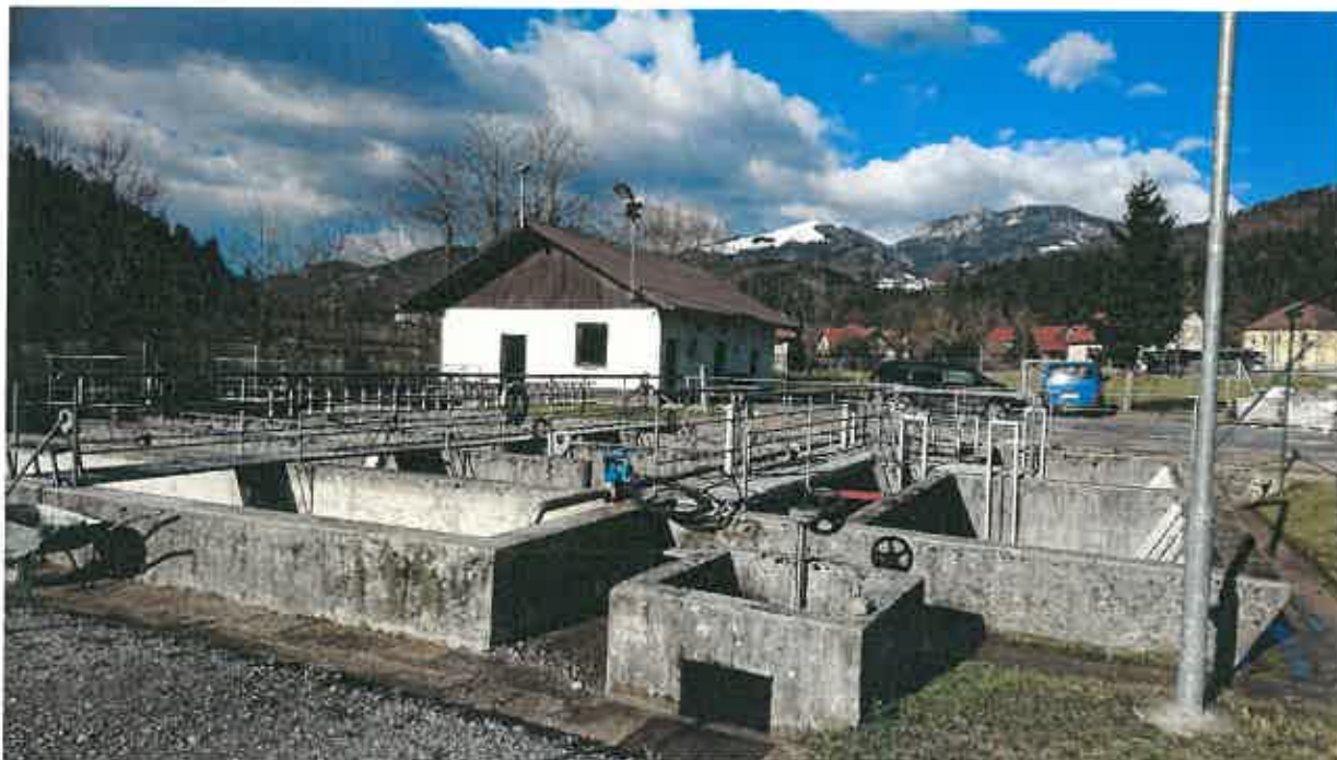
Foto: Čistilna naprava Gornji Grad
