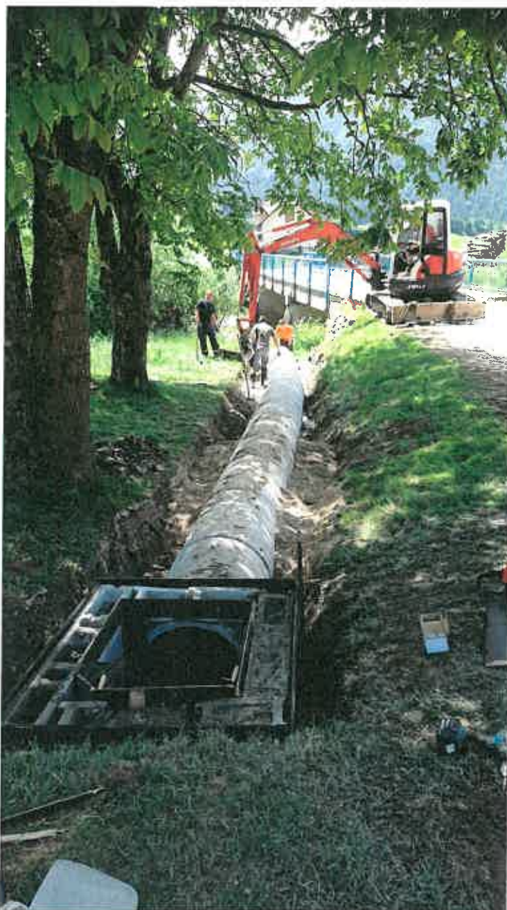
Foto: Podaljšanje propusta pri Kočnikih v Otoku
