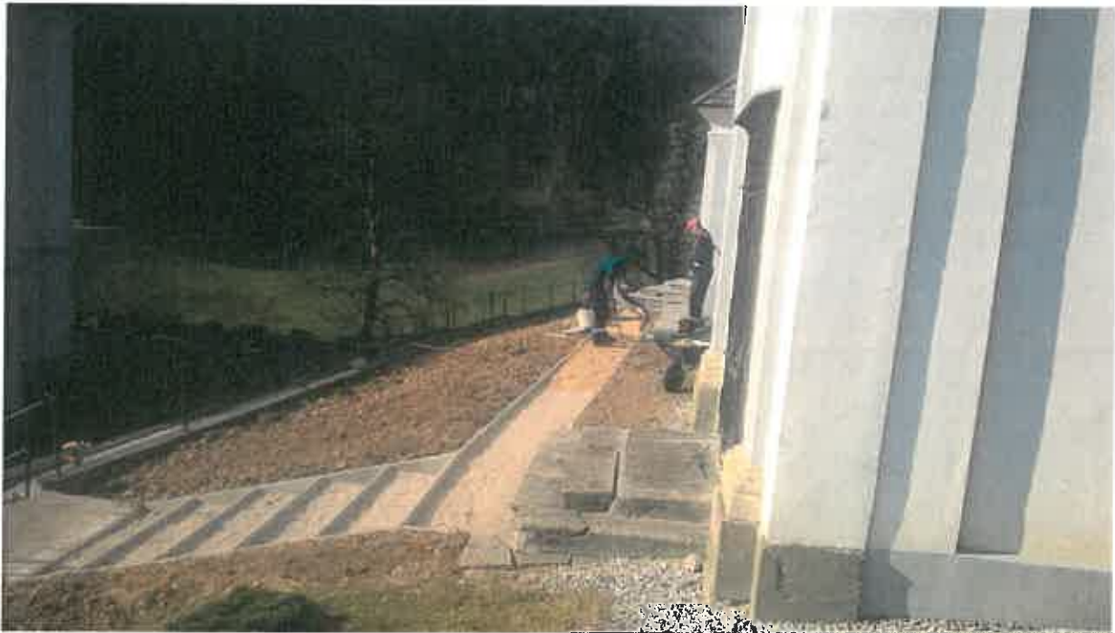
Foto: Izdelava novih stopnic in poti na pokopališču v Novi Štifi
