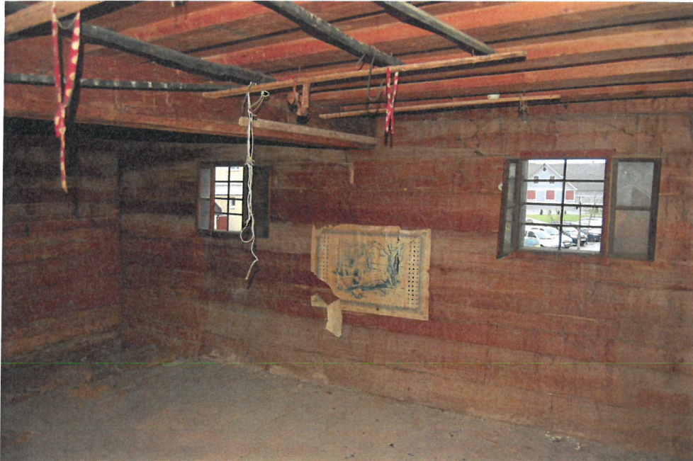
Notranjost nadstropja z brunasto konstrukcijo sten pred posegi, 8.4.2008
