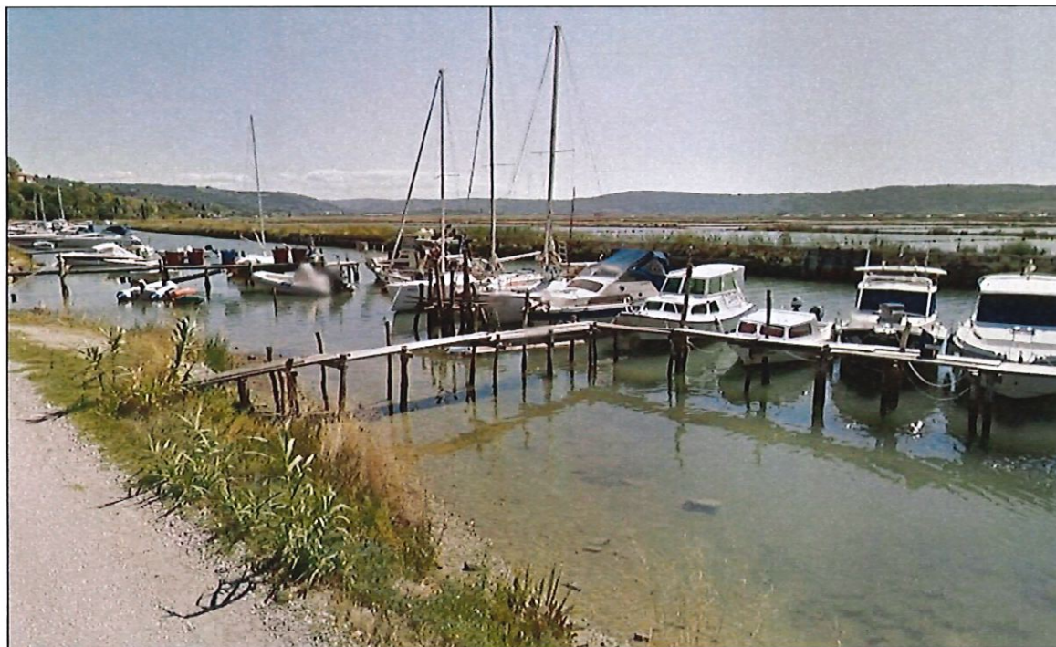
Slika 2: Improvizirani pomoli in mostovži, stihijska ureditev
