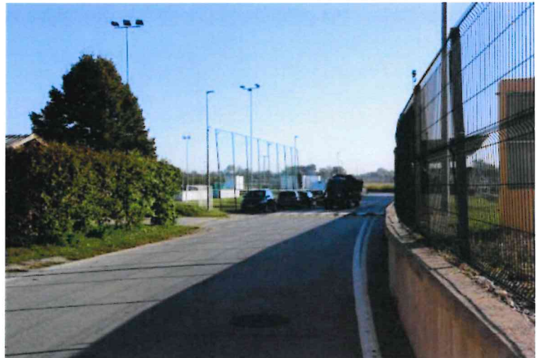
Slika 12: Lokalni cesta LC456210 (Videm - Markovci (jez)) odsek ob območju za šport
