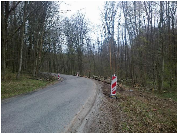
Zavarovanje nevarnega odseka ob cesti v Cogetincih
