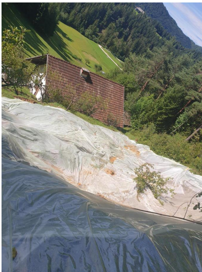
Slika 4: Zaščita plazu pred novim plazenjem nad stanovanjskim objektom Gornji Dolič 20A
