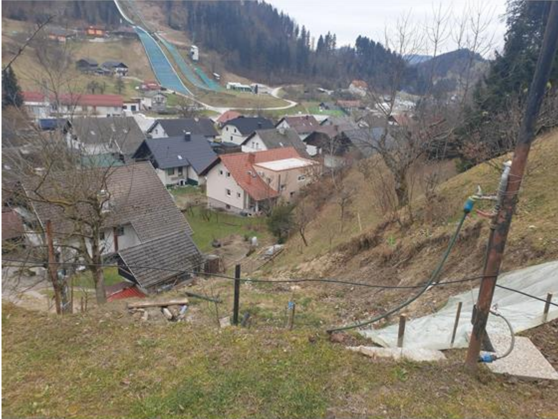
Slika 2: Stanje plazu na območju Gozdarska cesta 51, ID 1445990
