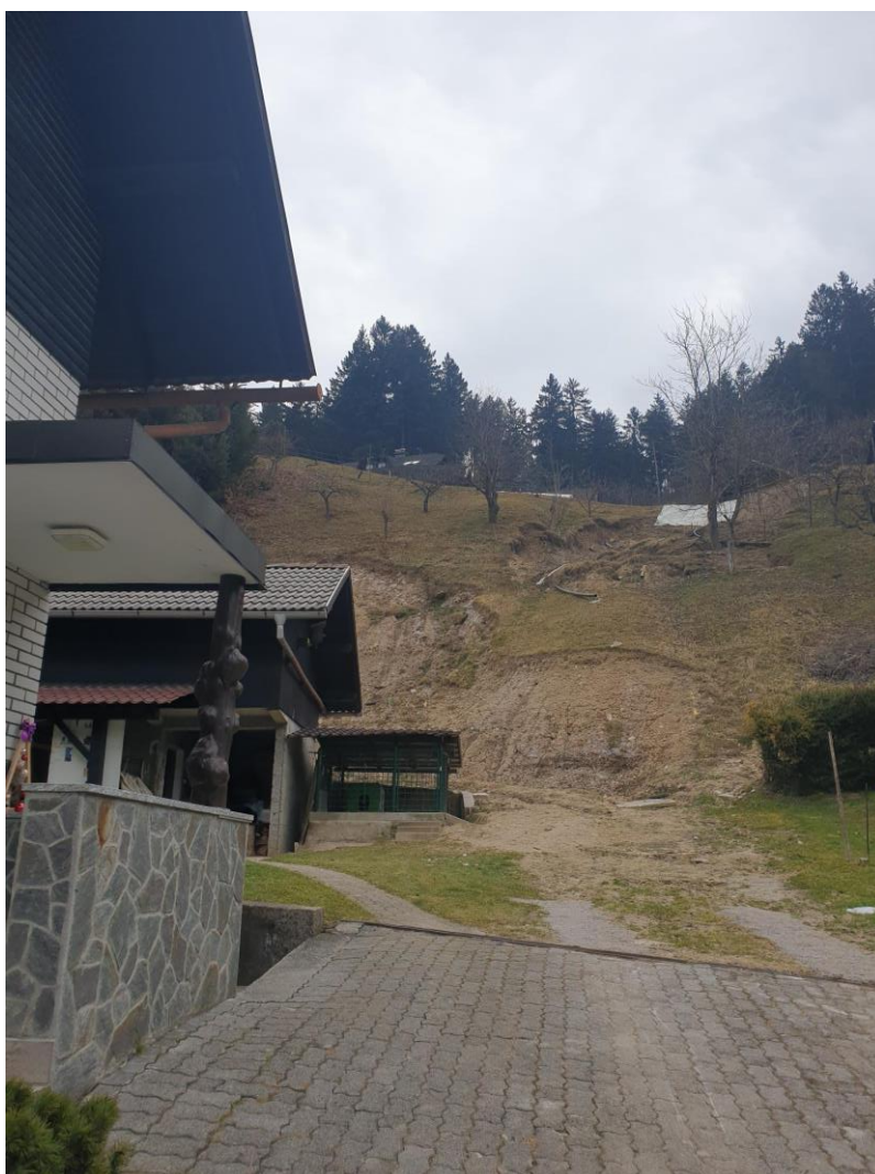
Slika 3: Območje plazu pri stanovanjski hiši Gozdarska cesta 51, ID 1445990
