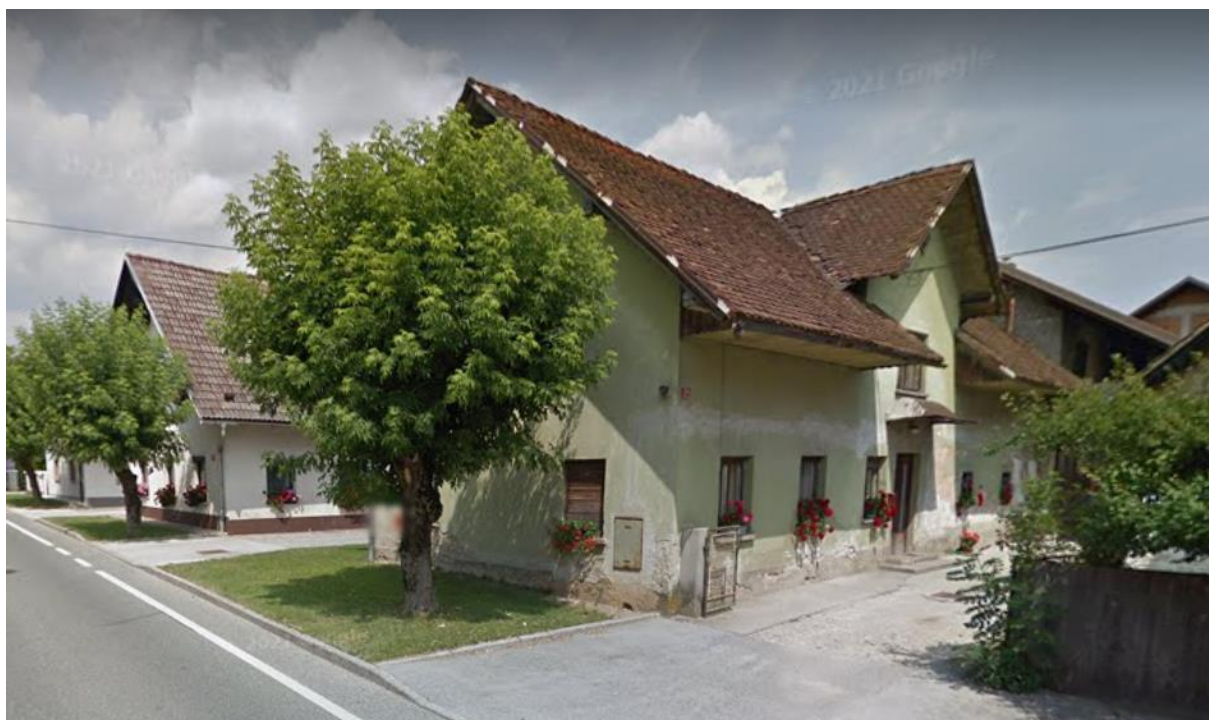
Slika 5: Fotografije lokacije pred rušitvijo starega objekta.
