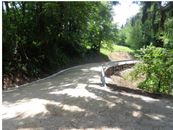
Slika 5: Območje sanacije plaz u po izvedenih delih
