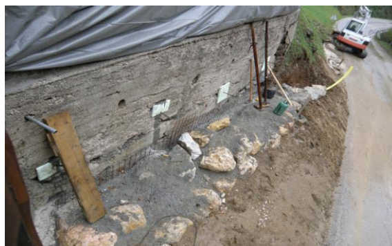
Slika 6: Med sanacijo zidu
