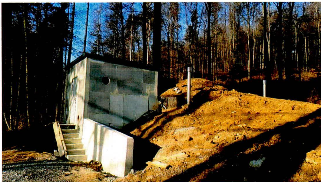
Slika 4: Obnova vodohrana Brezovica 2018
