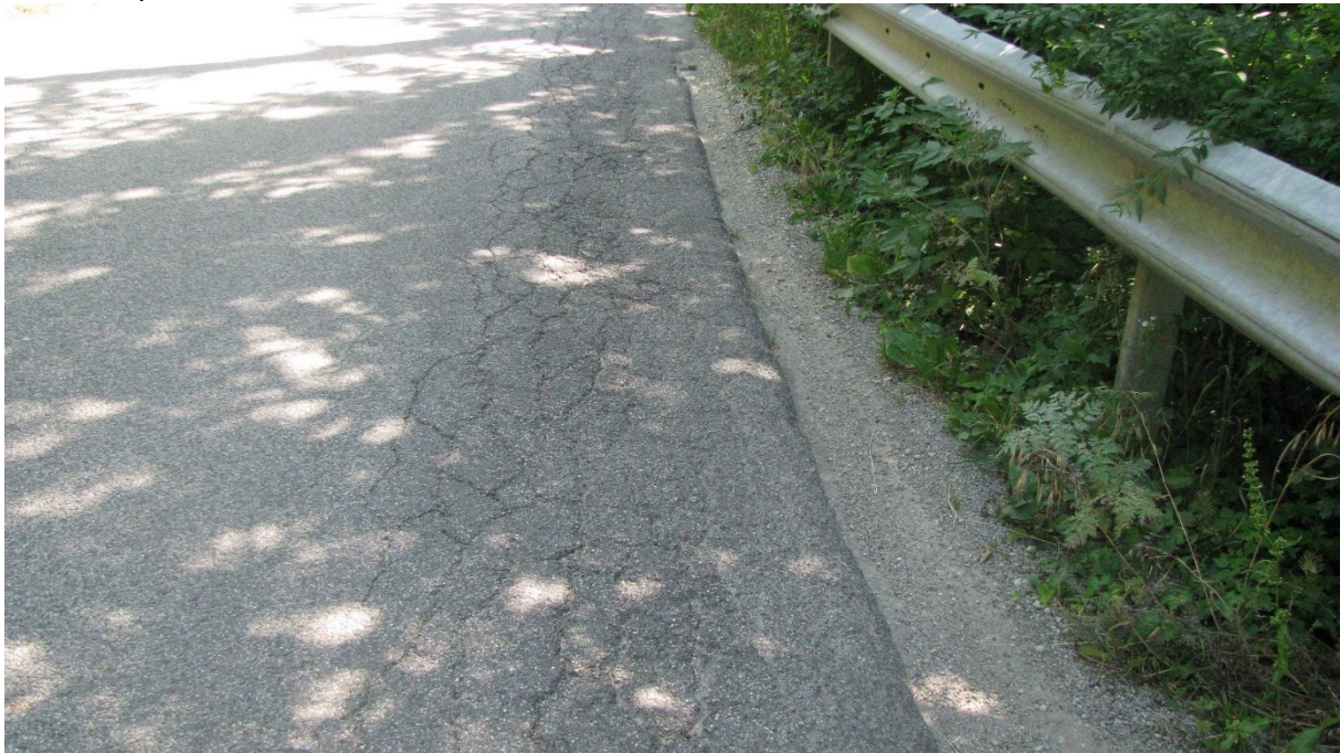
Slika: Razpoke ob robu vozišča
