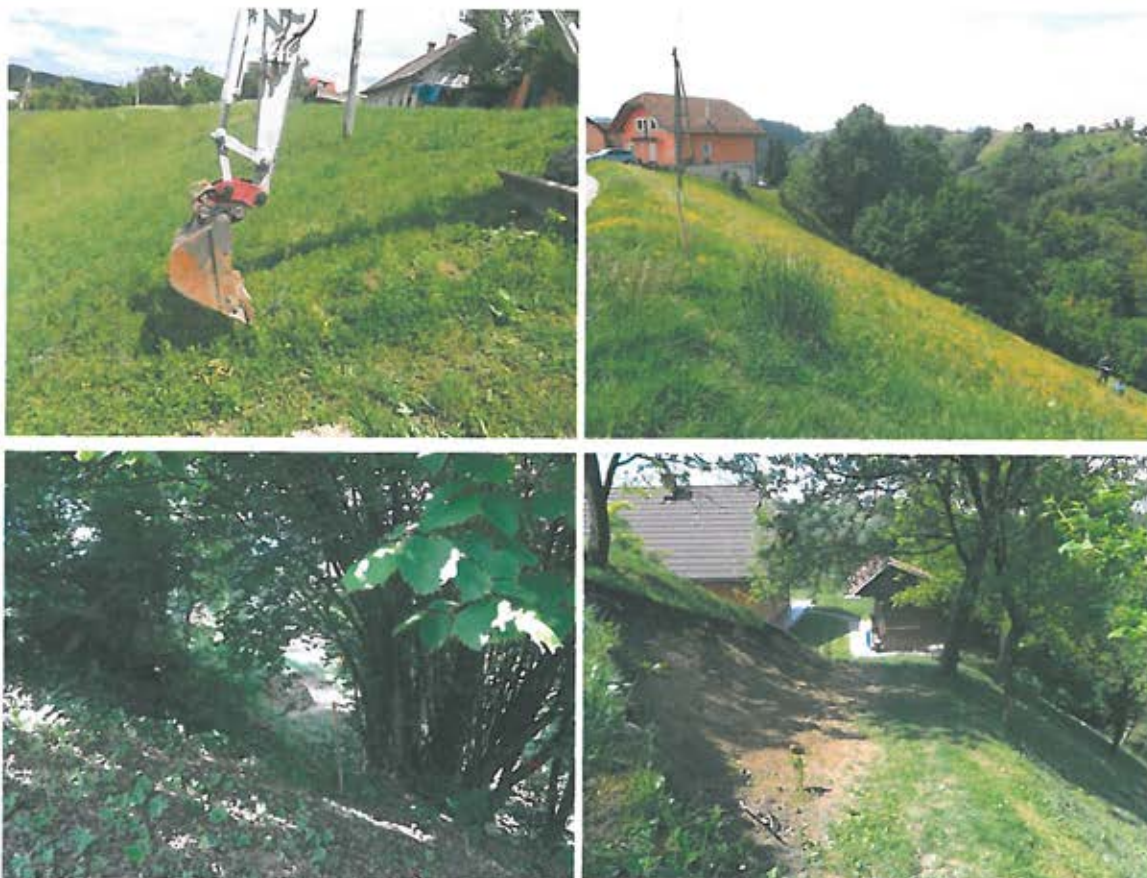
Slika 1: Območje predvidene trase. Začetek trase zgoraj. Območje predvidene kamnite zložbe (spodaj levo) in zaključek trase (spodaj desno).
