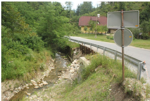
Pogled dolvodno na intervencijsko izvedbo zagatne stene z namenom zagotovitve prevoznosti ceste.
