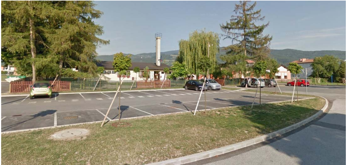
Slika 3-4: Obstoječe stanje - vrtec
