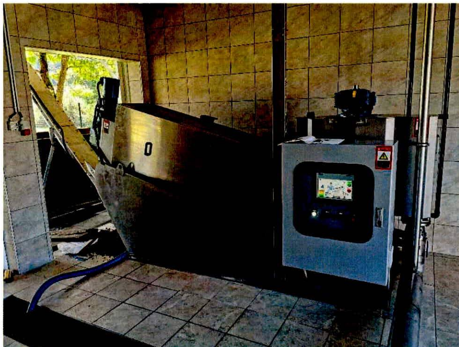
Slika 3: nova počasi rotirajoča dehidracijska naprava
