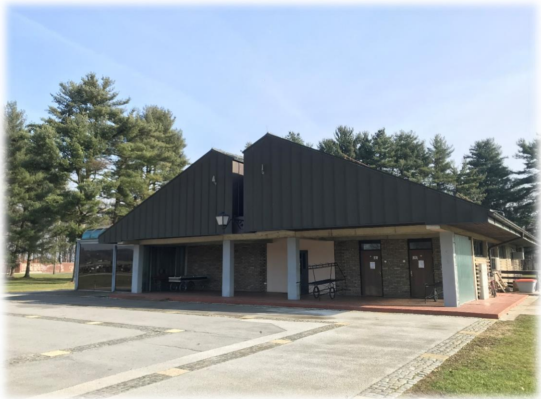
Slika 2: Obstoječe stanje vežice
