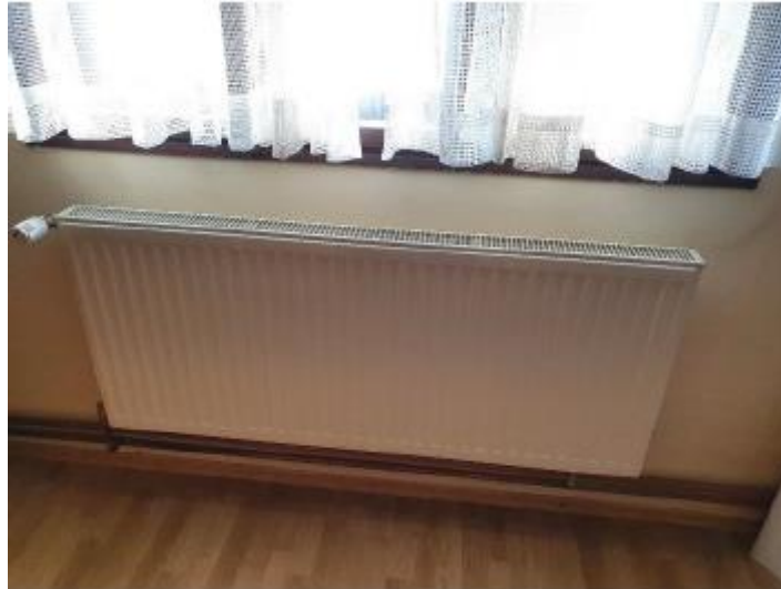
Slika 27: Radiator s termostatskim ventilom
