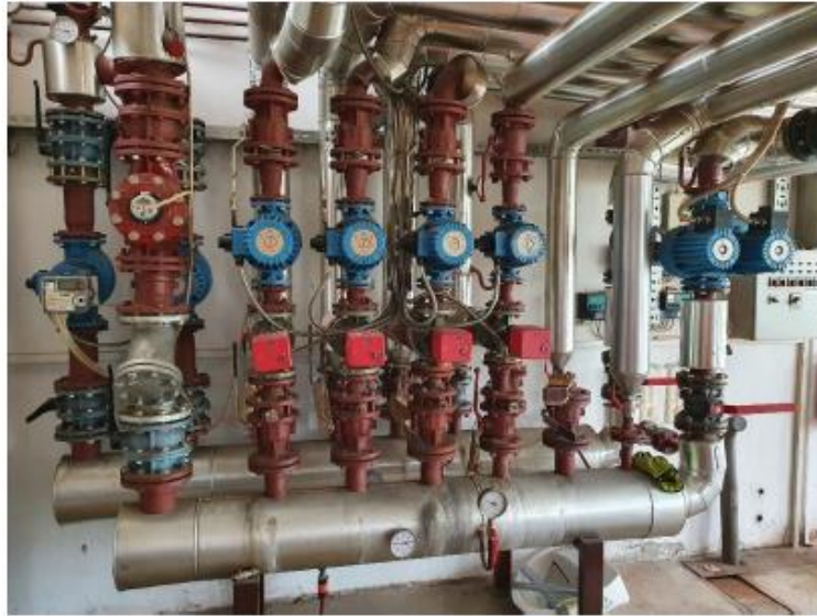
Slika 35: Ogrevne veje s obtočnimi črpalkami
