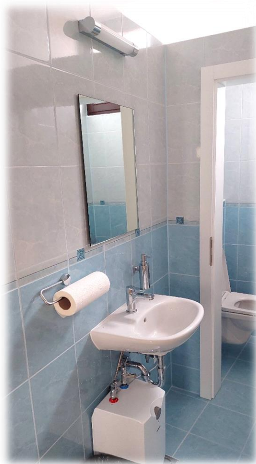
Po sanaciji sanitarij v Mladinskem oddelku (foto: Alfonz Zavrnik).
