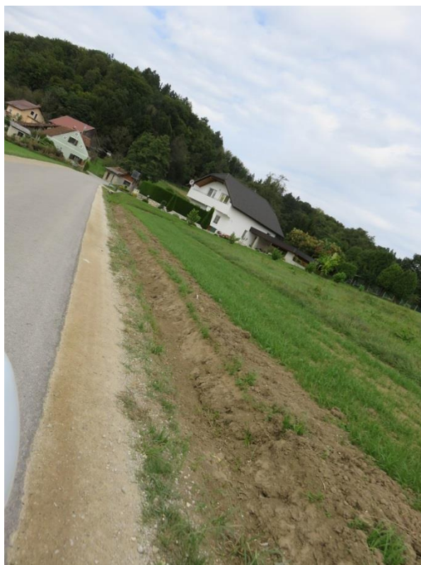
Slika 4: Vzpostavitev občestnega jarka
