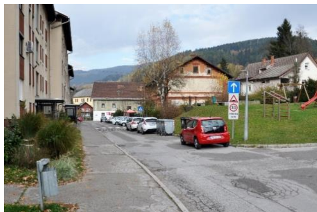
Slika 9: Odsek kolesarske povezave
