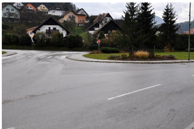
Slika 2: Odsek kolesarske povezave
