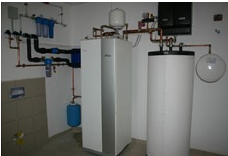
Slika 9.2: Toplotna črpalka s hranilnikom toplote.
