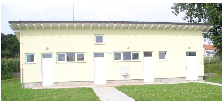
Slika 3.10: Sanitarni prostori športnega igrišča.
