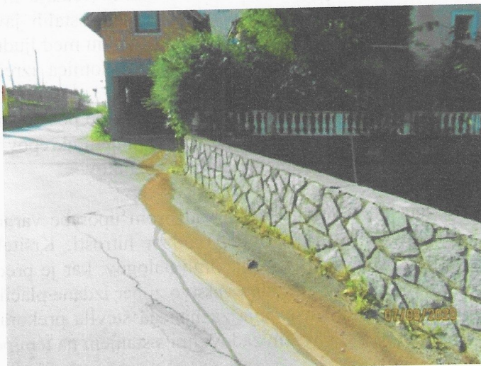
Slika 2: Primer iztekanja meteorne vode na občinsko cesto.
