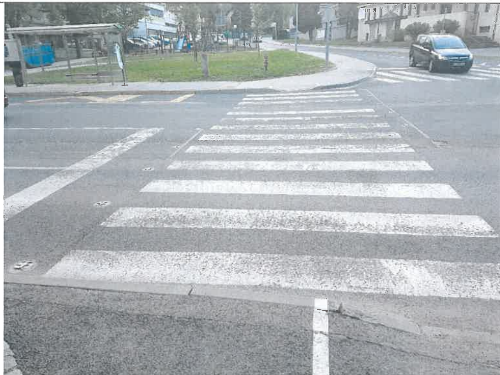
Pogled na prehod za pešce (dolga pot pešca preko vozišča)
