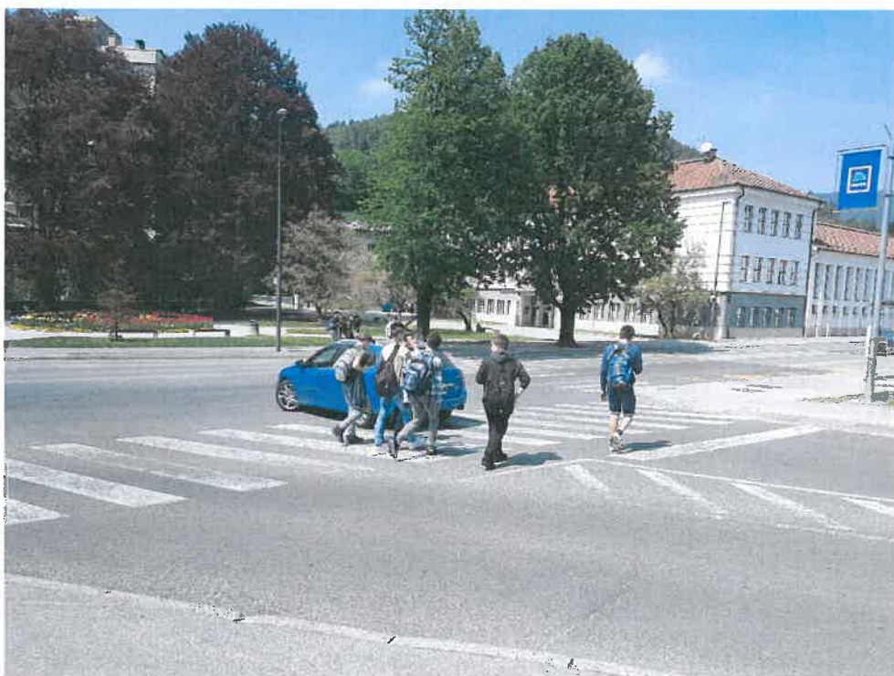
Zaradi premajhnega odmika prehoda za pešce od navideznega roba GPS se vozila na SPS ustavljajo neposredno na prehodu za pešce
