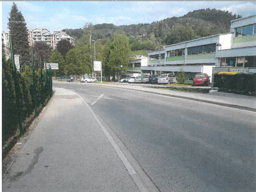
Preglednost iz desne strani prehoda v levo zaradi ograje in poteka ceste v krivini omejena
