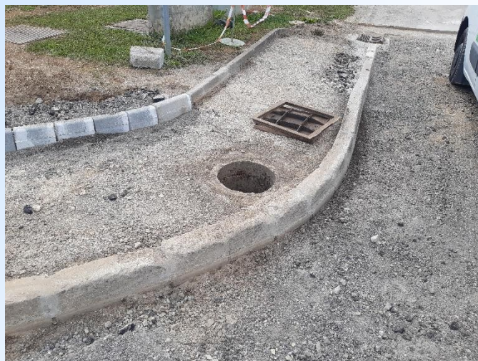
Slika 37: Polaganje robnikov in popravilo jaška
