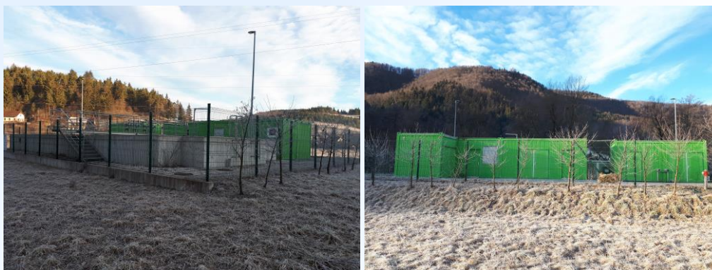
Slika 21: Čistilna naprava Sodražica
