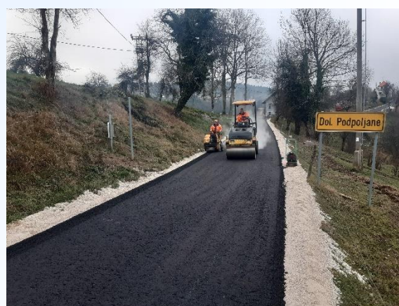
Slika 47: Asfaltiranje ceste Dolenje Podpoljane
