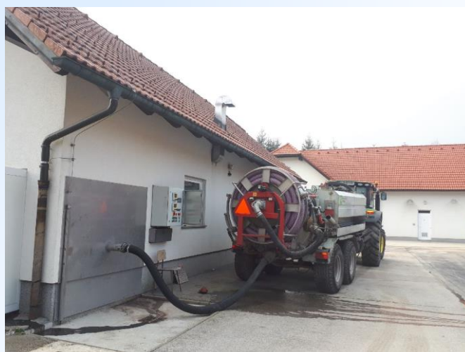
Slika 27: Praznjenje cisterne v zalogovnik grezničnega blata na ČN Ribnica
