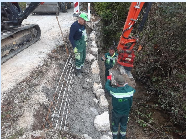
Slika 38: Oporni zid Črni Potok
