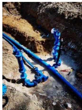
Montaža podzemnih hidrantov
