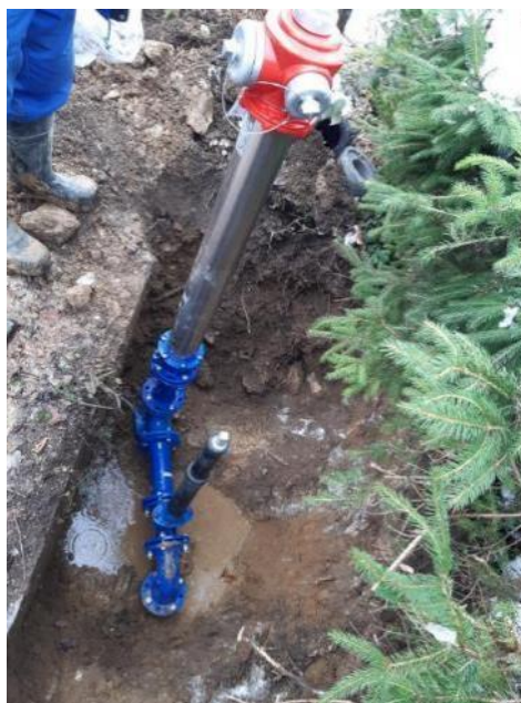
Zamenjani hidrant- Mačkovec
