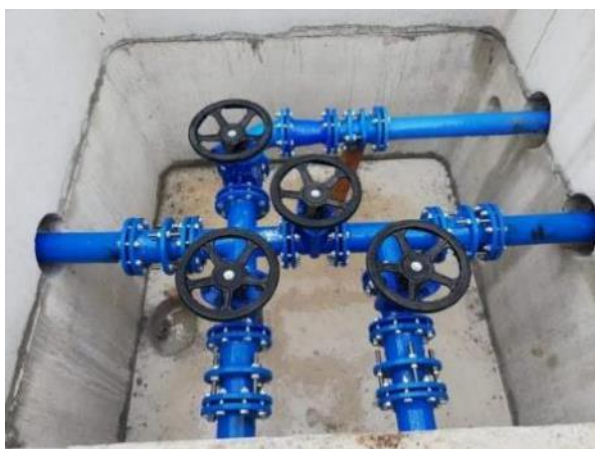
Izgrajen krmilni jašek
