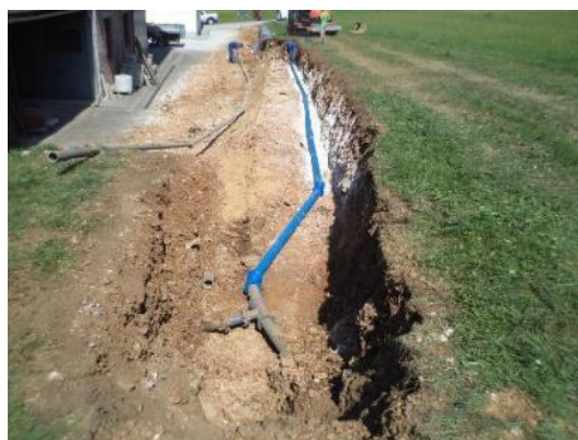
Montaža podzemnih hidrantov
