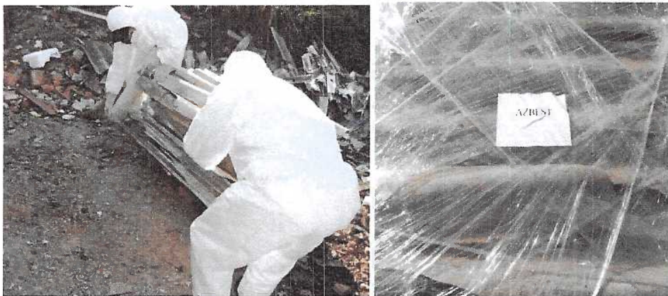
Slika: Sanacija divjega odlagališča azbestno cementnih odpadkov ter pravilno zavita paleta z azbestnimi odpadki
