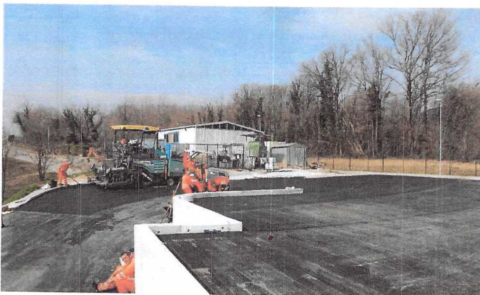
Slika: Zbirni center CERO Nova Gorica v fazi izgradnje
