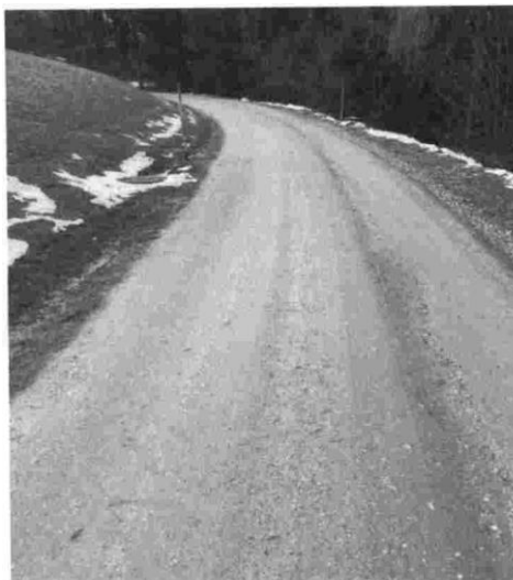
Slika 4: Pogled na konec meje obdelave na lokalni cesti LC 350371 (pri profilu P138)
