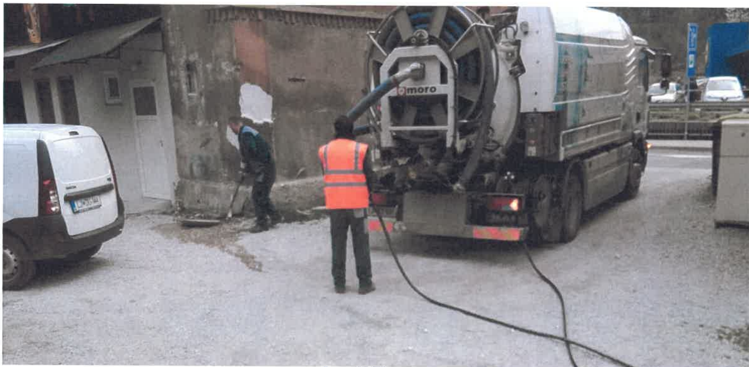
Slika 5: Čiščenje greznice
