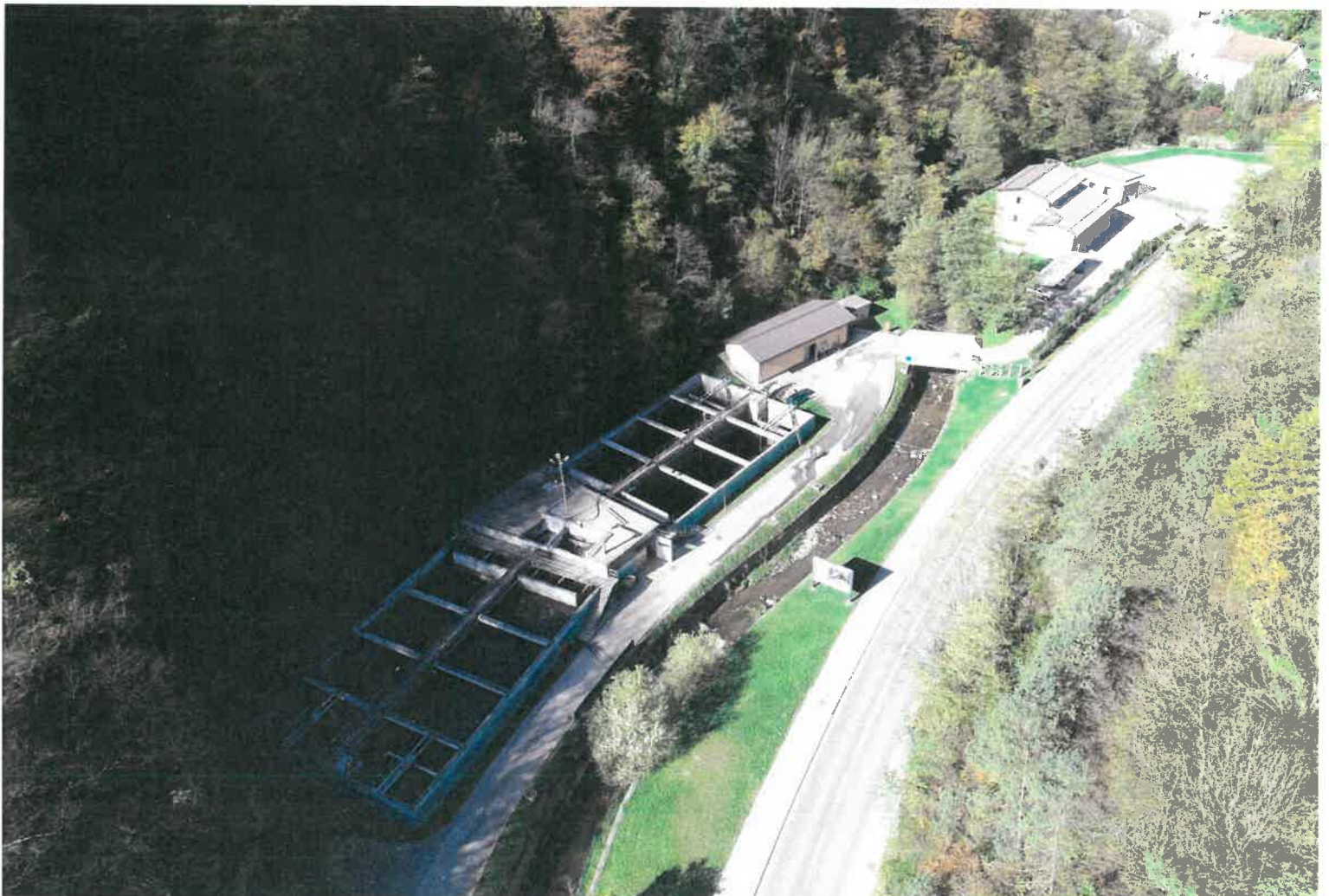
Slika 2: Centralna čistilna naprava
