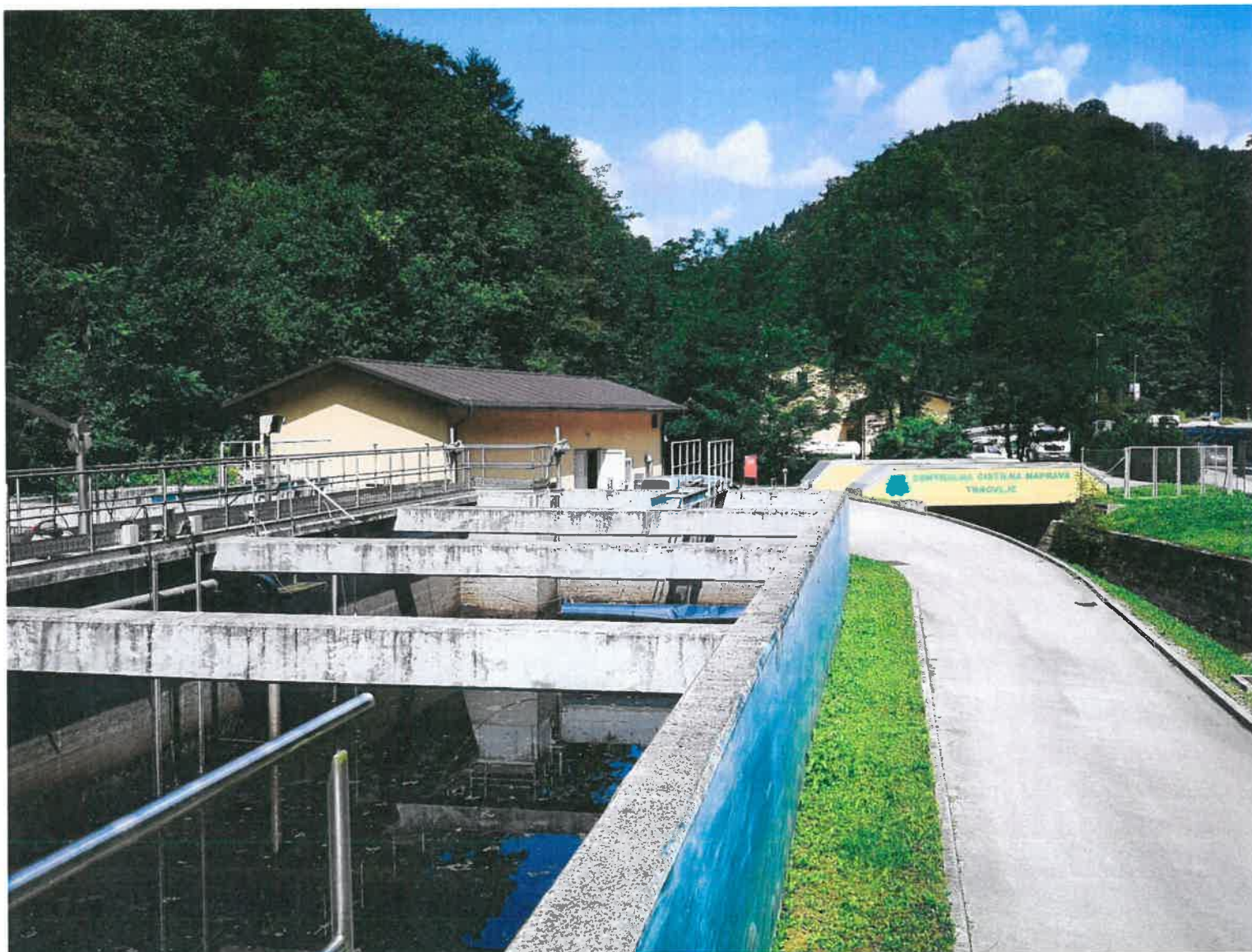
Slika 3: Pogled z bazenov centralne čistilne naprave
