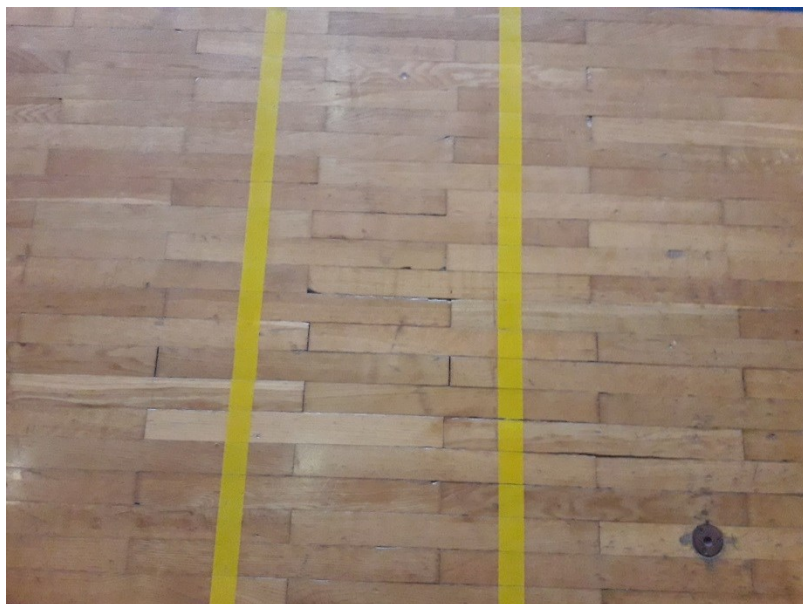
Slika 1, 2, 3: Fotografija - obstoječe stanje telovadnice
