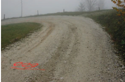
Slika 6: Blagi travni jarek na vkopni strani serpentine z vtokom v obst. prepust BC \Phi 300 . Iztok iz prepusta.
