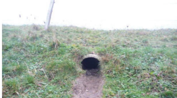
Slika 6: Blagi travni jarek na vkopni strani serpentine z vtokom v obst. prepust BC \Phi 300 . Iztok iz prepusta.
