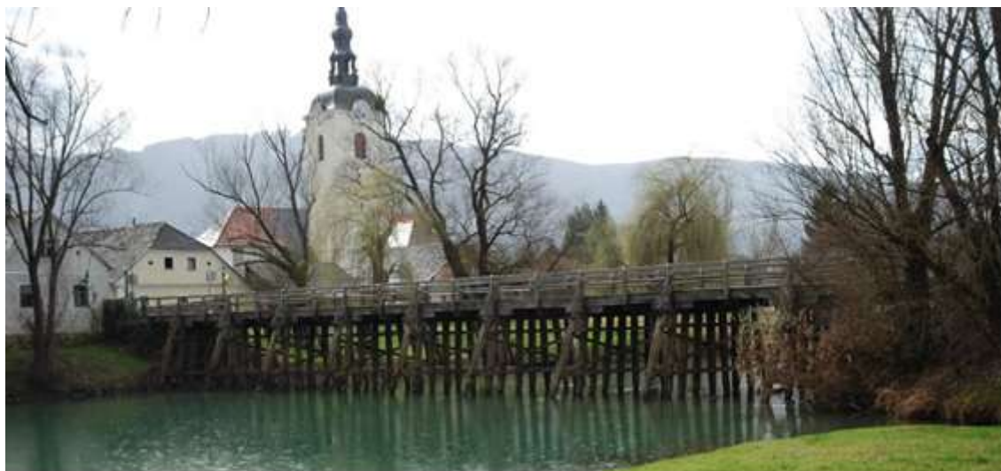
Slika 4: Pogled na severni most
