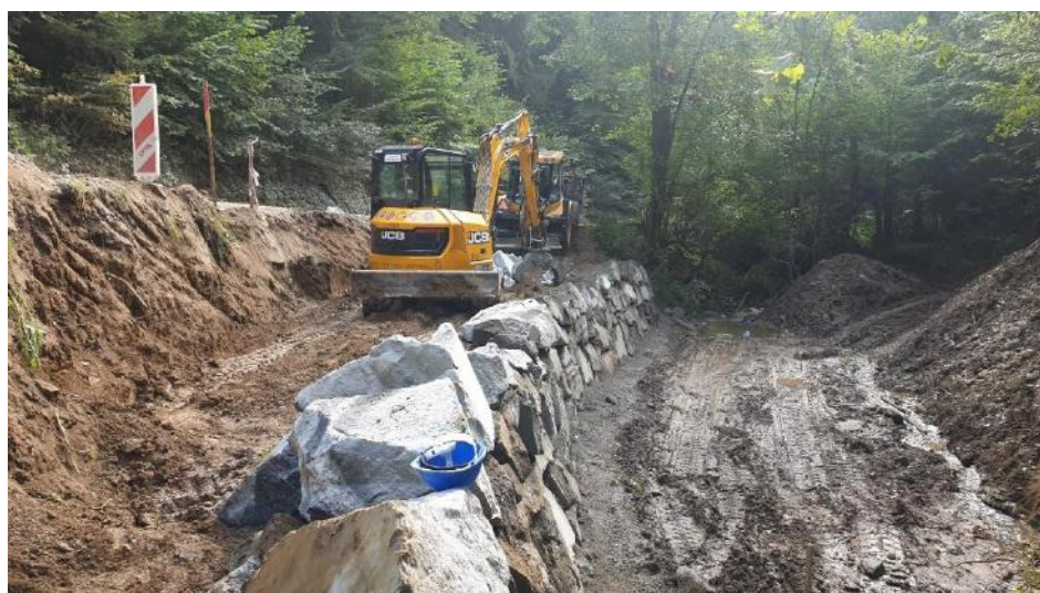
Sanacija plazu na LC Jamce – Zarja
