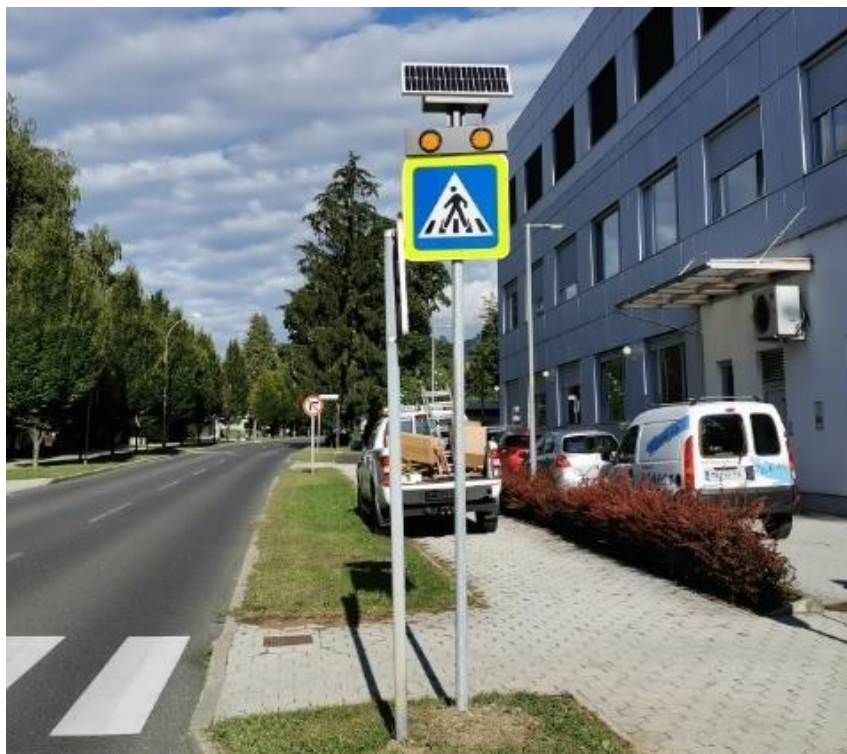
Postavitev vertikalne signalizacije na Partizanski ulici
