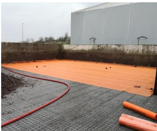
Čiščenje in priprava biofiltra
