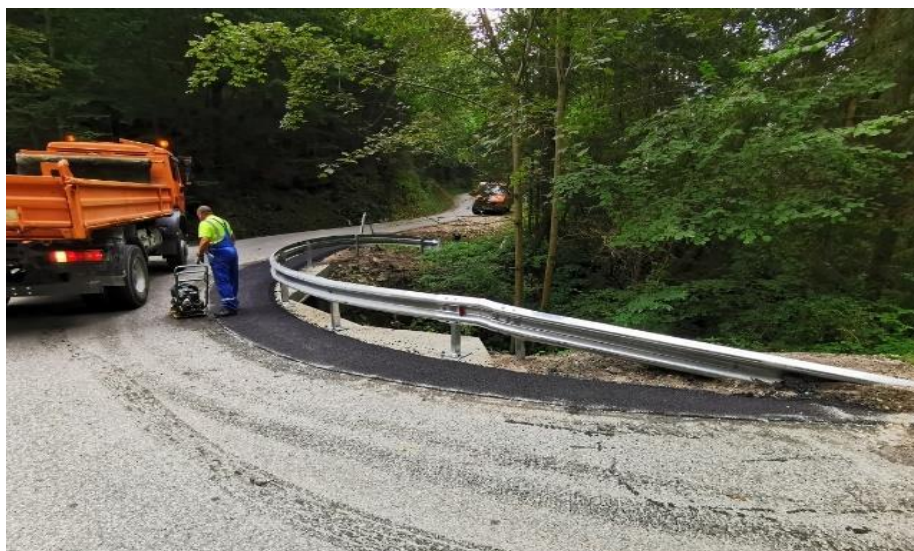
Razširitev mostu, krila ter postavitev JVO, LC Malo Tinje – Sl. Bistrica
