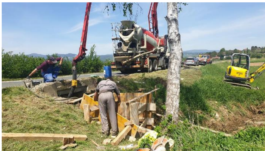
Sanacija prepusta na LC Sl. Bistrica - Pečke
