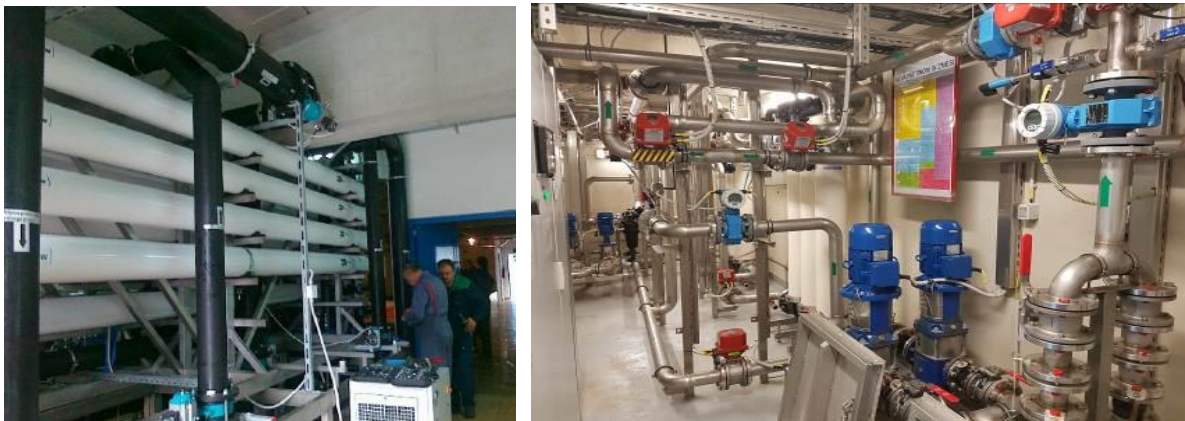
Priprava pitne vode s postopkom UF na Vodarni Zg. Bistrica in Jelovcu
