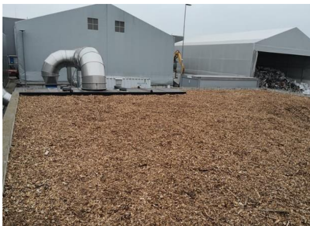
Čiščenje in priprava biofiltra
