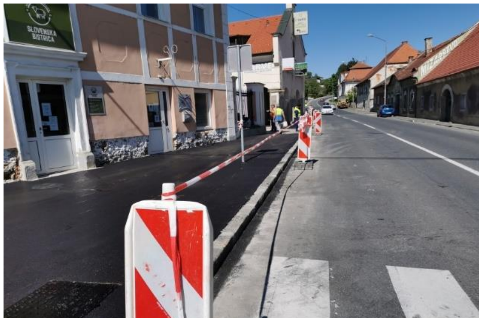
Izgradnja hodnika za pešce na Mariborski ulici
