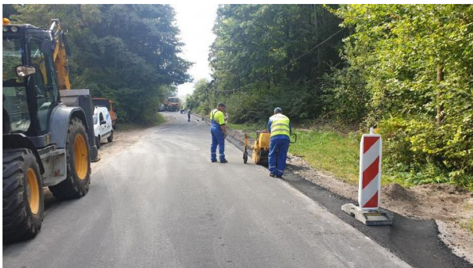
Izdelava asfaltnih muld na lokalnih cestah
