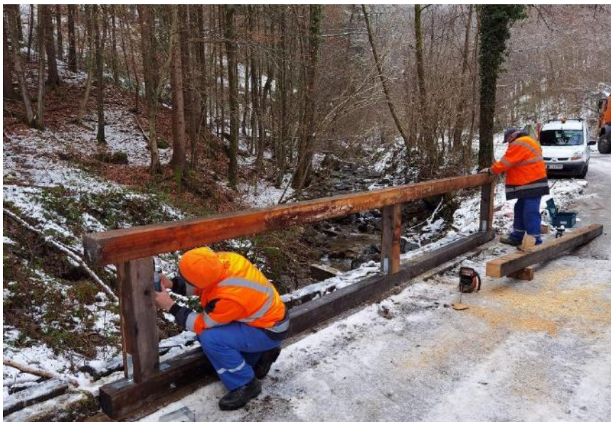
Popravilo lesene mostne ograje na lokalni cesti v Frajhajmu
