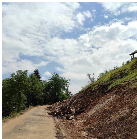
Slika: Cesta Tabor v gradnji
