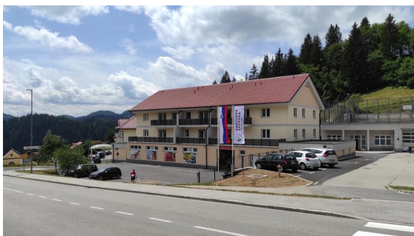
Slika: Dokončan Medgeneracijski center Hrib 103
