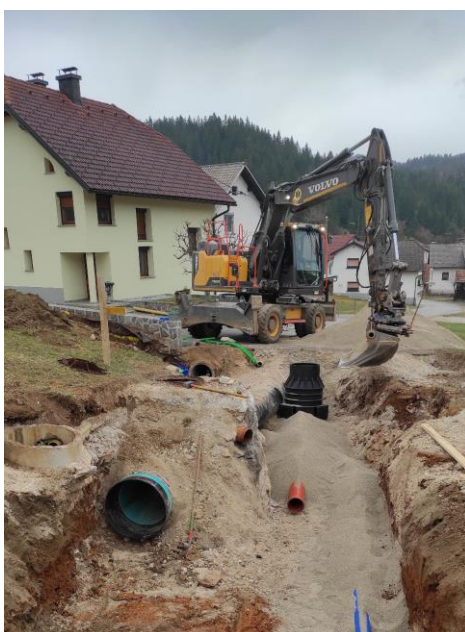
Slika: Obnova ceste, fekalne kanalizacije, vodovoda Srednja vas
