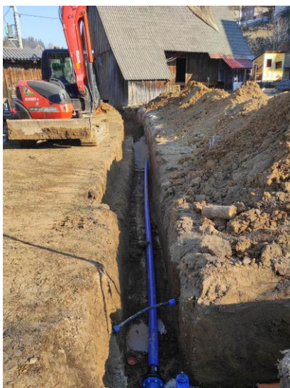
Slika: Obnova vodovoda Travnik
