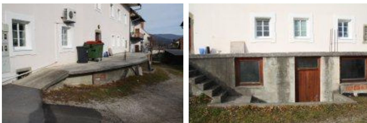
Slika 14: Neurejena zunanost občinske stavbe.
