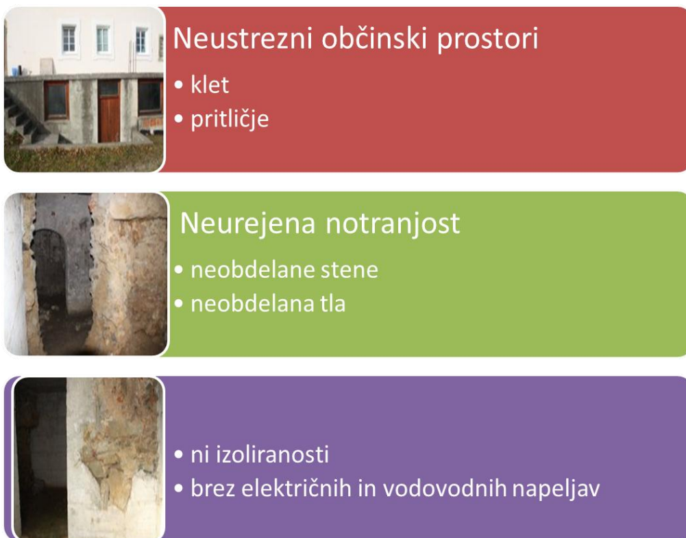
Slika 12: Fotografije in opis trenutnega stanja občinskega objekta.
