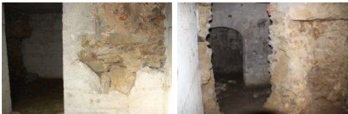
Slika 15: Neurejeni kletni prostori občinske stavbe.
